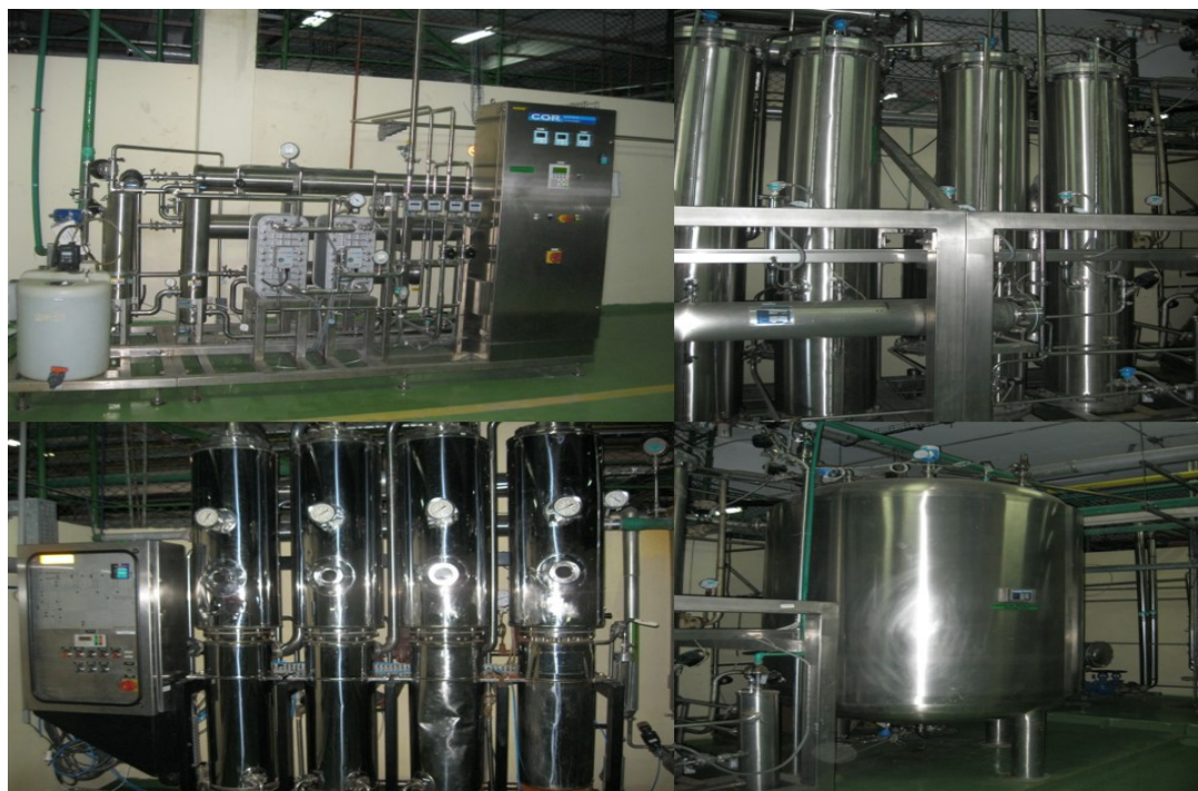
Figura 18. Sistema de producción de PW y WFI (Elaboración propia).
